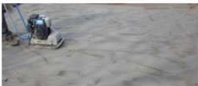
Zagęszczone mechanicznie
