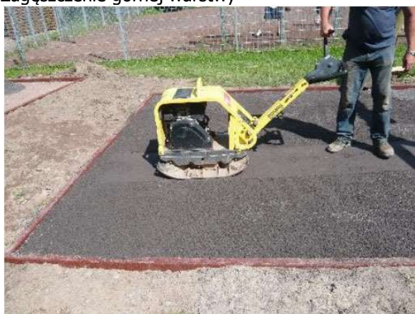
Zagęszczenie górnej warstwy
