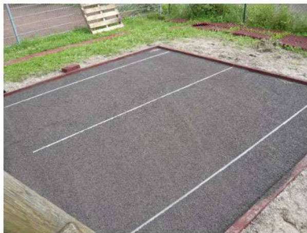
Wyrównanie górnej warstwy
