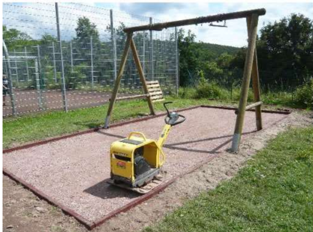
Zagęszczenie górnej warstwy
